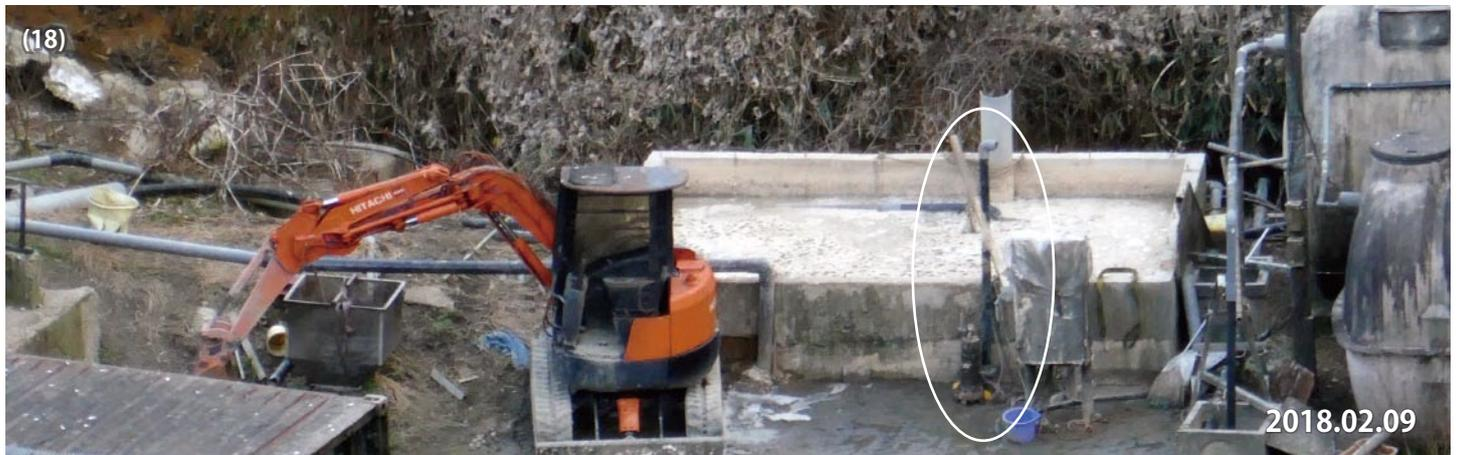
2018年2月初め頃、汚水槽から汚水を噴き上げていたパイプが汚水槽から取り出され、汚水槽の外に置かれた。水中ポンプがついているのがわかる。
