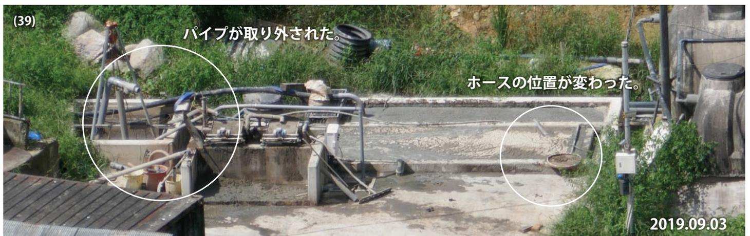
2019年9月3日には縦穴から伸びるパイプが外され、排水設備は機能していなかった。このように村田養豚場は、新しい排水設備の完成後もしばしば配管を変更しており、新しい排水設備が安定して稼働しているようには思われない。なお木津川市には新しい排水設備の詳細が伝えられていない。
