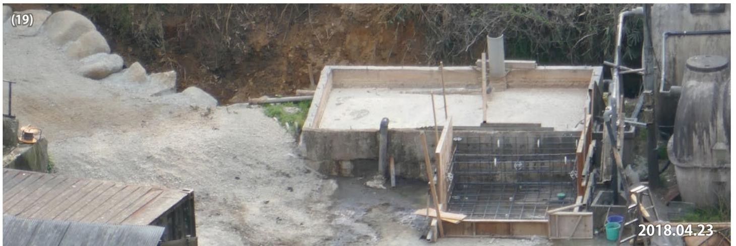
2018年4月中頃、汚水槽脇にコンクリート台の型枠が作られた。このコンクリート台はのちにのちに固液分離装置の台として使われる。
