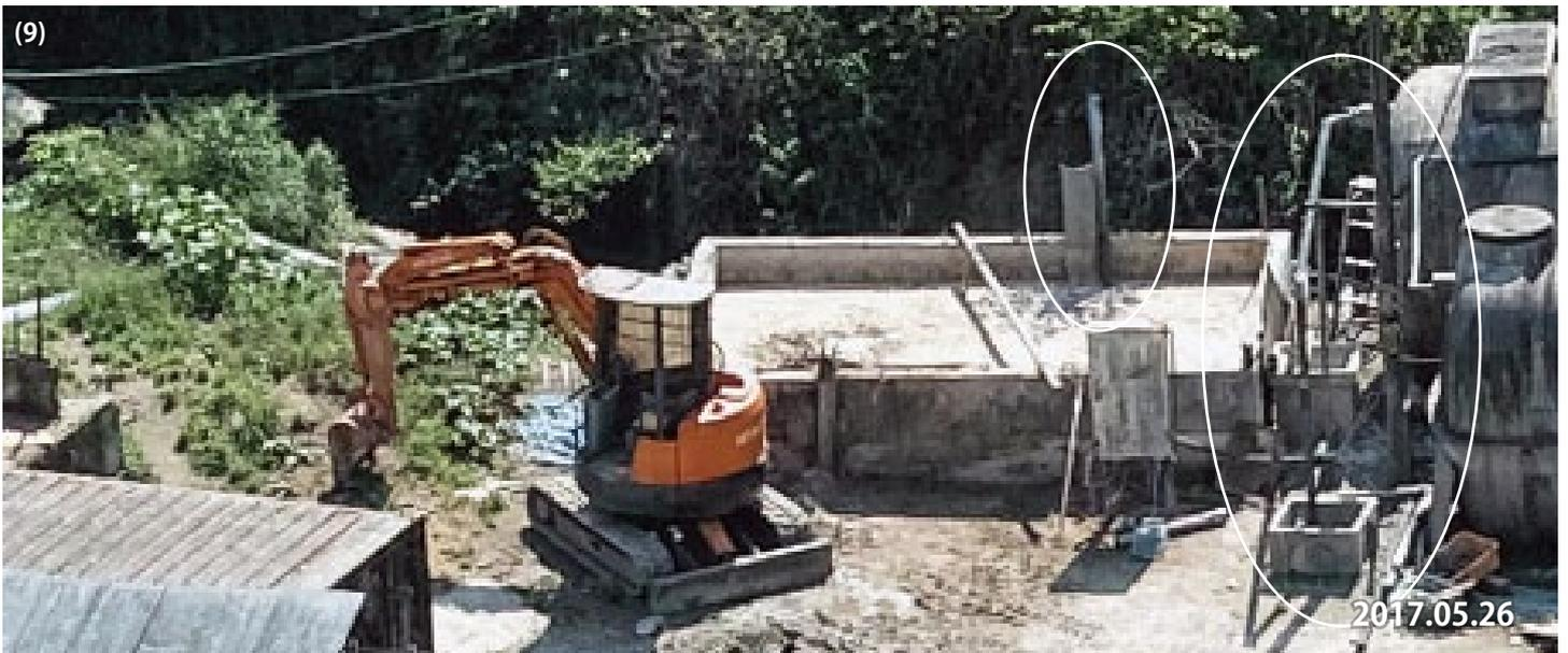
汚水槽から突き出したパイプが短くされ、汚水槽と古い浄化槽の間に新しくパイプが配管された。
