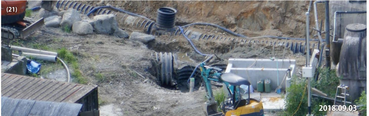
2018年9月初め頃、木津川市の国有水路工事と並行して汚水槽及び2017年5月に設置された配管が撤去され、素掘りの穴とされた。穴は暗渠管で土留めされていた。これまで豚舎北西端の地下に集められた汚水が暗渠管を通して汚水槽に流し込まれていたが、その暗渠管の出口が見えている。
