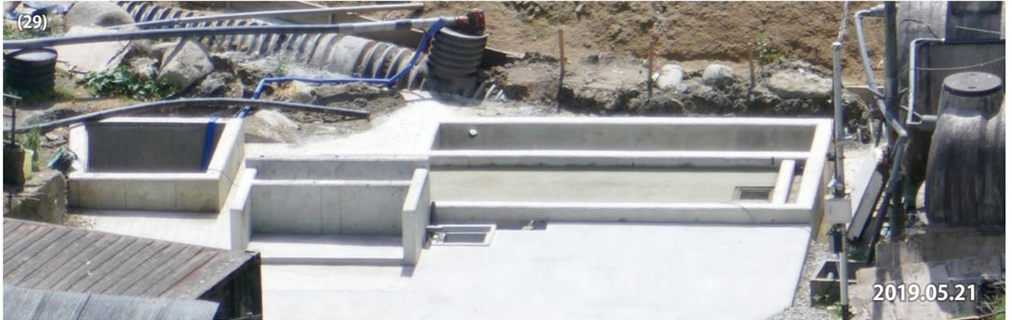
2019年5月下旬には、一時撤去されていたコンクリートの台が新しい槽の脇に据え付けられ、排水設備の周囲にコンクリートが敷かれた。
