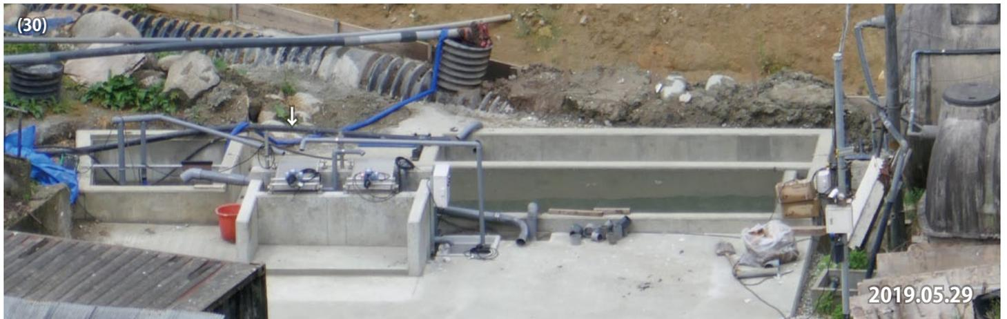
2019年5月末にはコンクリート台に振動節が二台取り付けられ、配管もほぼ完成した。水路と反対側の浅い槽に溜まっているのは雨水とみられる。水路側の深めの槽から写真左側に伸びているパイプは、水路側の槽に溜まった水を豚舎北西端の縦穴に戻しているとみられる。
