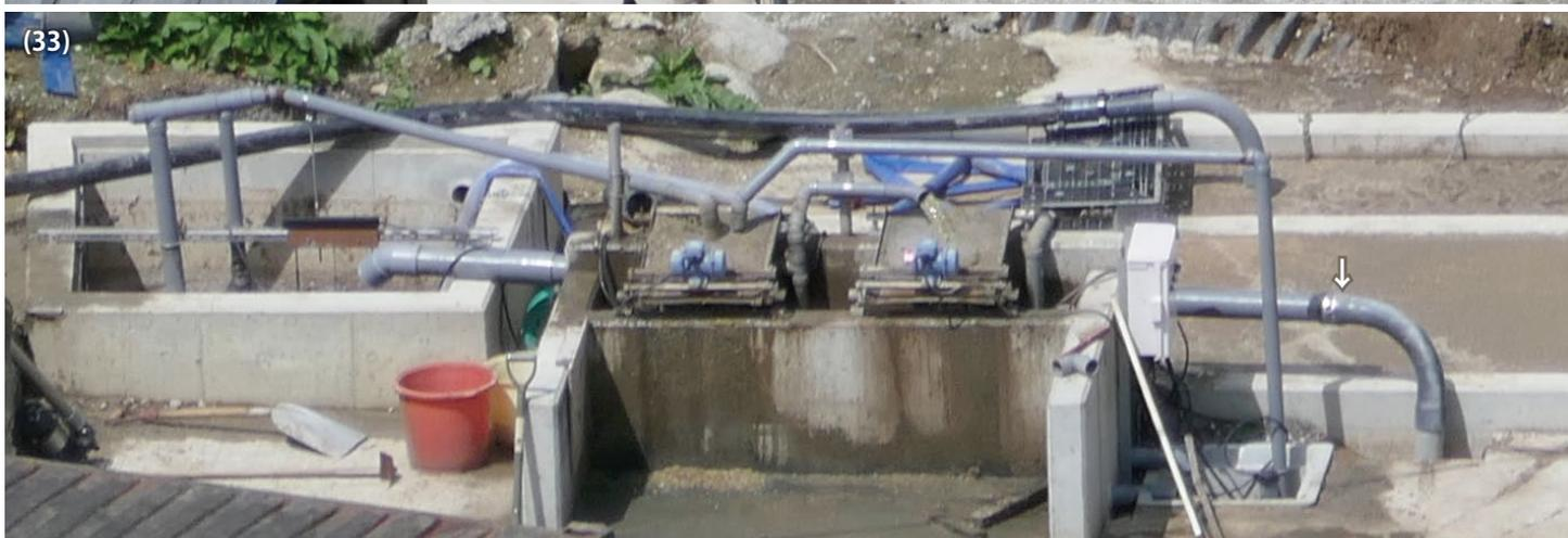
2019年6月中頃、新しい排水設備が稼働を開始した。しかしすぐに配管が変更され、汚水槽脇から突き出たパイプが暗渠管の縦穴に差し込まれた。
