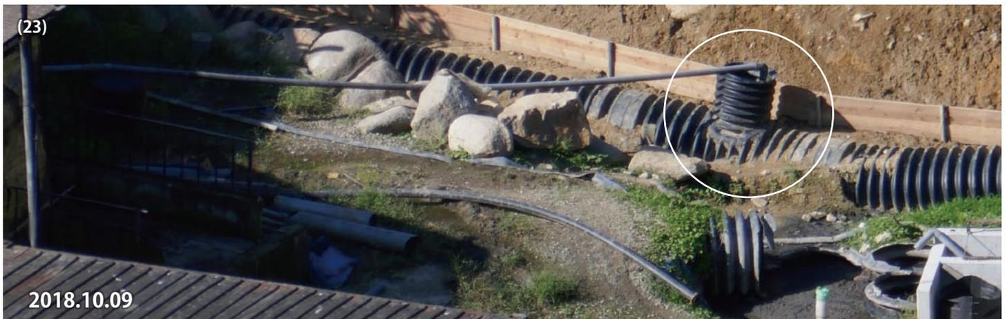
2018年10月初め頃、豚舎北西端にある地下の汚水溜まりに通じている縦穴から伸びたパイプが、水路の暗渠管の縦穴に差し込まれた。
