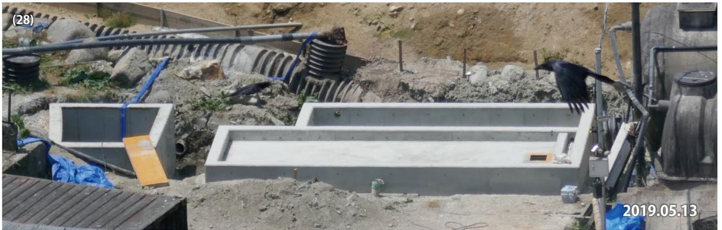
2019年5月中頃には、新しい汚水槽のコンクリート枠が完成した。
