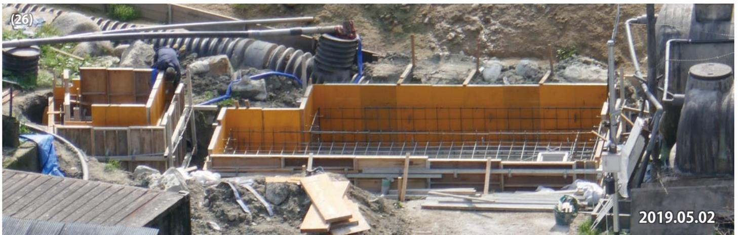
鉄筋の間隔が25cm程度とすると、水路側が深さ1m・幅6m・奥行き1.5m程度、水路の反対側が深さ15cm・幅7.5m・奥行き1.5m程度の槽となる。
