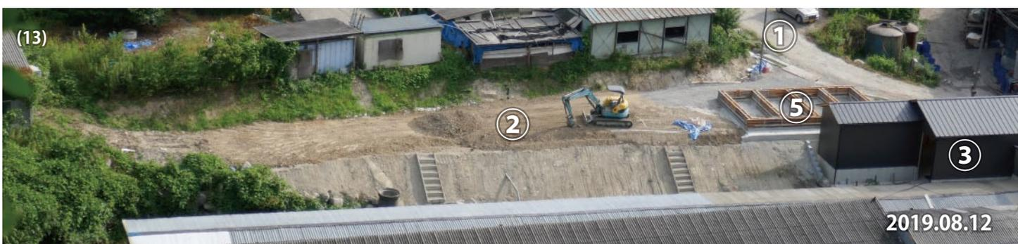
建設業者Hは2019年8月初め頃から、新しいプレハブ小屋(5)を建設している。また、それと並行して東側豚舎南の崖の上に土を積み増し、露出していた大岩による段差をなくす工事を行なった。
