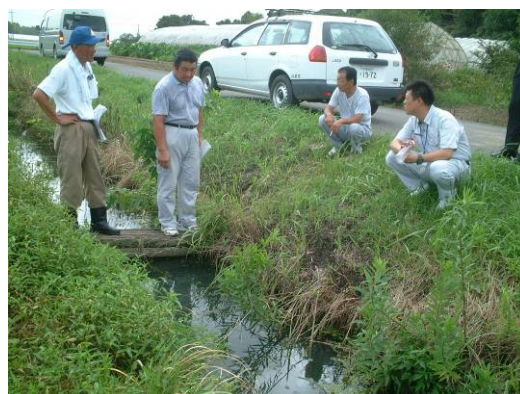
設置前の水路②の状況(2006 年 8 月)
