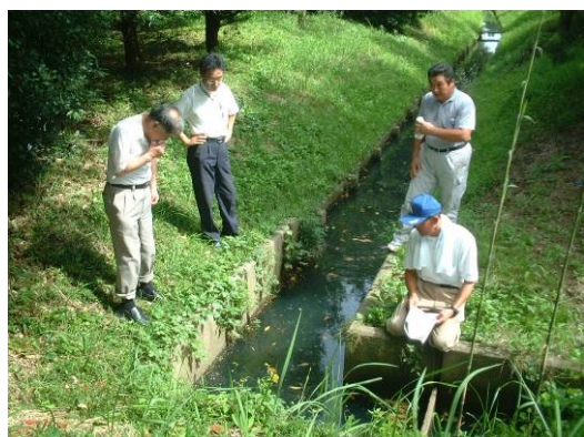
設置前の水路①の状況(2006 年 8 月)
